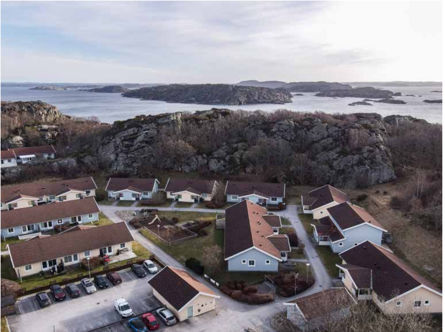
Rödbergsvägen 10-60 i Rönning.
