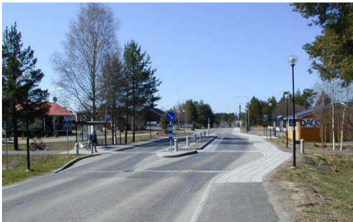
Figur 10: Exempel på enkelstoppållplats från väg 692 i Råneå norrbottens kommun, fotot är hämtat från exempelbanken.se
