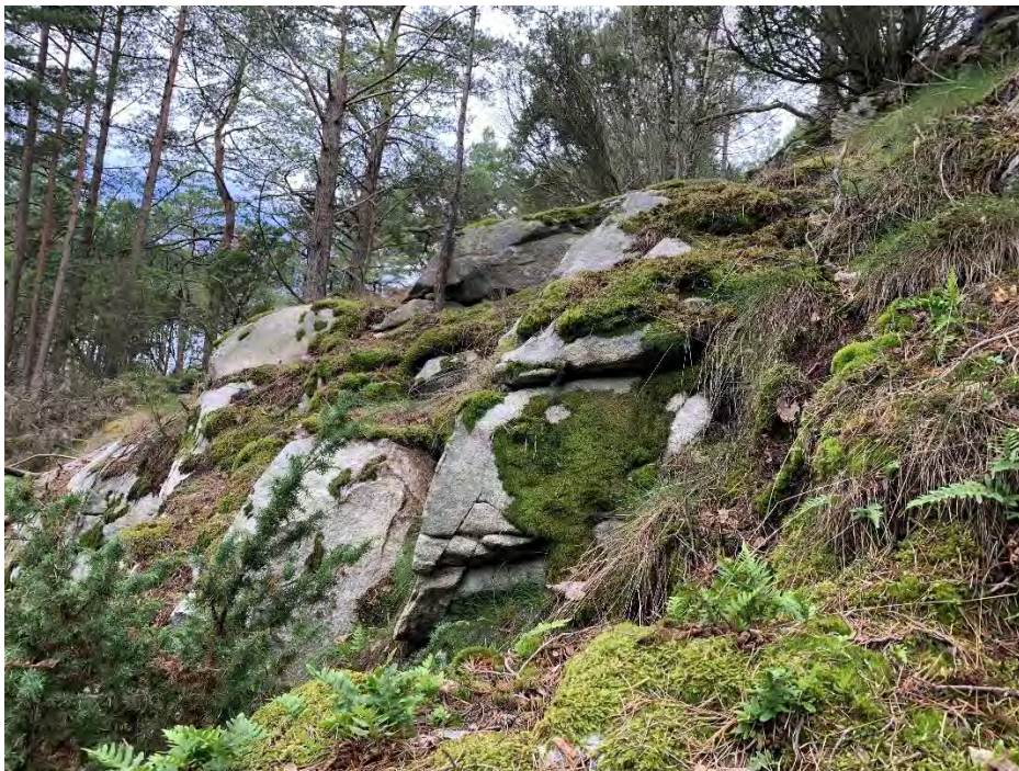
Figur 4.3. Granit med högre blockuppsprickning, stabil i dagsläget.
