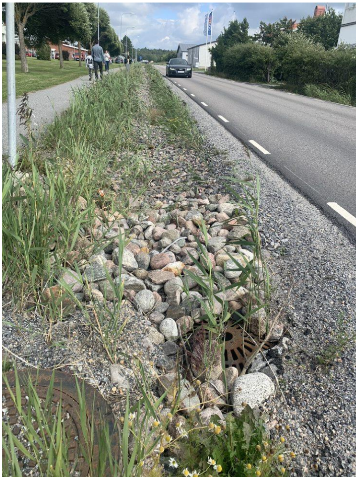
Figur 15. Exempel på makadamdike längst med väg.
