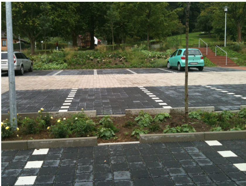
Figur 17. Exempel på nedsänkt växtbädd på parkering.
