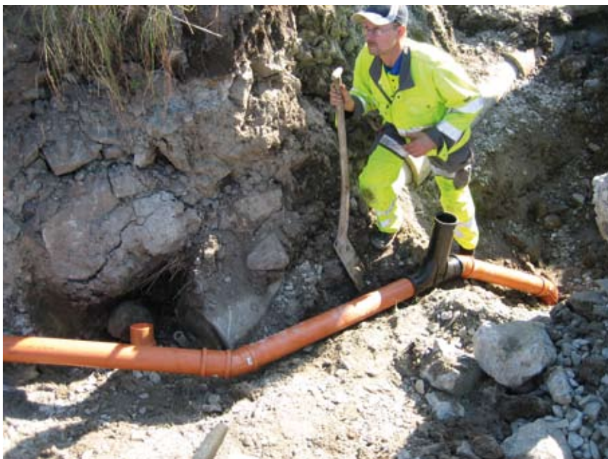
Arbetet med utbyggnad av VA-ledningar pågår för fullt
