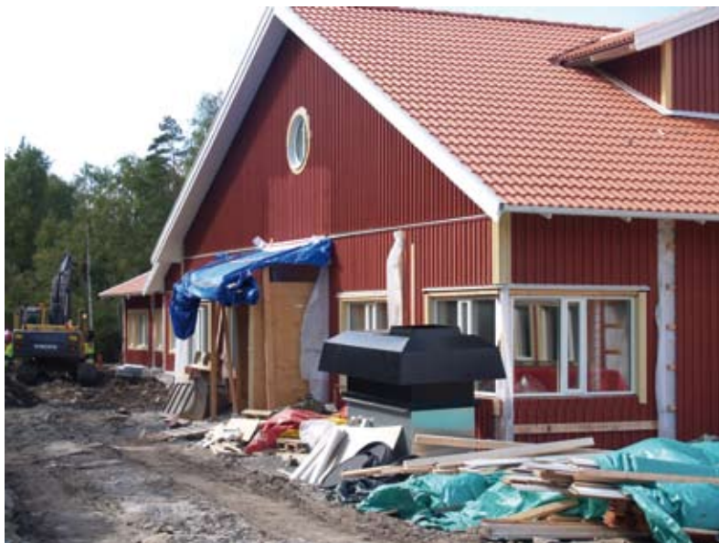
Klövedals äldreboende under byggnation.
