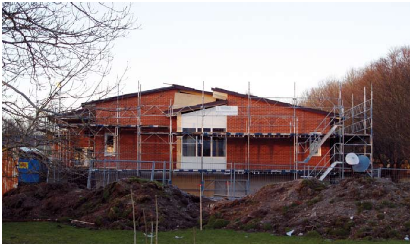
Större investeringsprojekt som är påbörjade är bl a ombyggnad och tillbyggnad av Rehabavdelning på Lilldals sjukhem.
