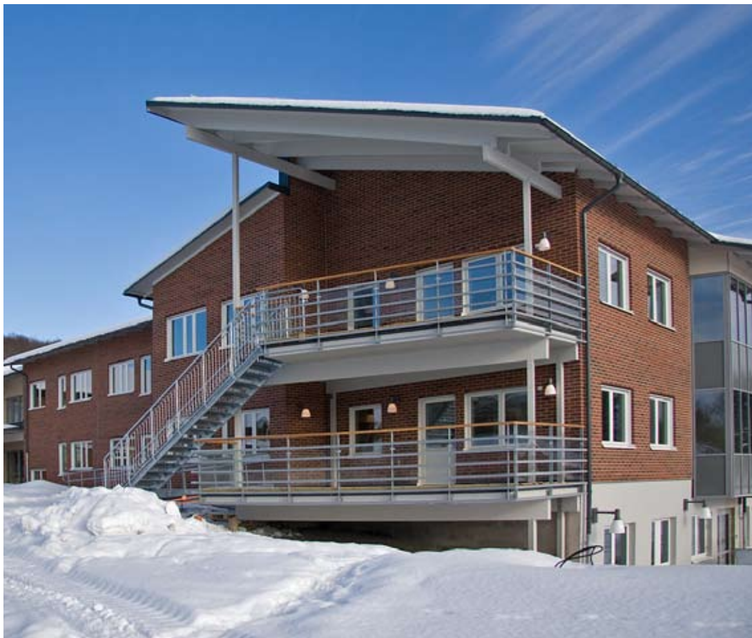
Valåsens äldreboende i Källekärr. Foto: Maria Johannessen
