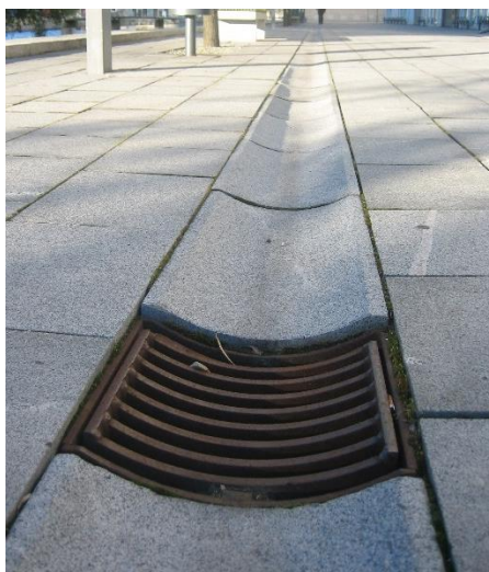
Figur 12 Exempel på stenlagd dagvattenrännna, vilket kan användas föreslås för de lokalgator där kantsten mot GC-väg saknas.
