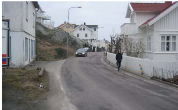
Storgatan - gångbana saknas
