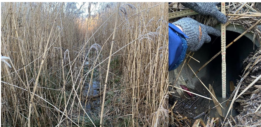
Figur 2-5. Dike längs fastighetens södra gräns (bild t.v.) som mynnar i betongtrumma (bild t.h.).
