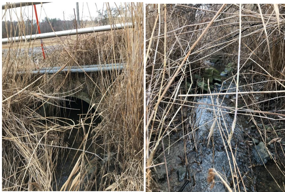
Figur 3-7. T.v.: Kulvert under väg vid punkt A. T.h.: Dike från punkt A mot punkt B.
