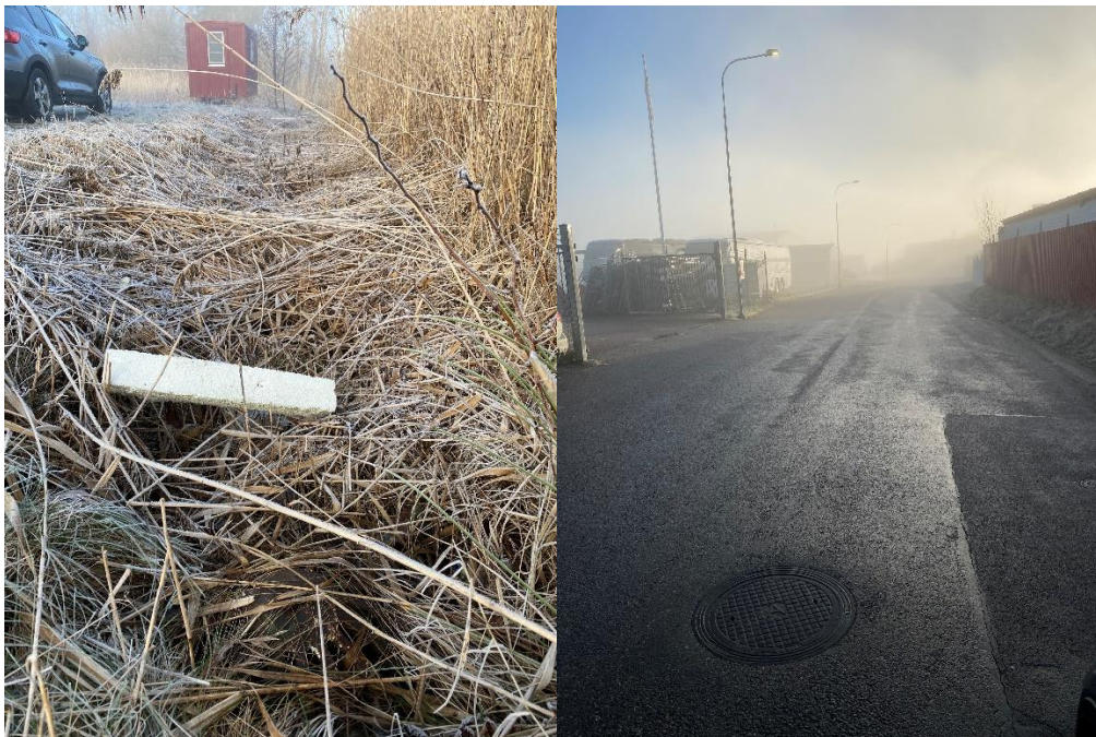
Figur 2-6. Kupolsilsbrunn kan skymtas (t.v.) i dike innan hårdgjord yta (t.h.) tar vid.
