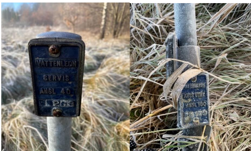
Figur 2-3. Vattenskyltar som påträffats inom planområdet vid fältbesök. Till vänster påvisar en 40 mm ledning medan foto till höger påvisar en 160 mm ledning.
