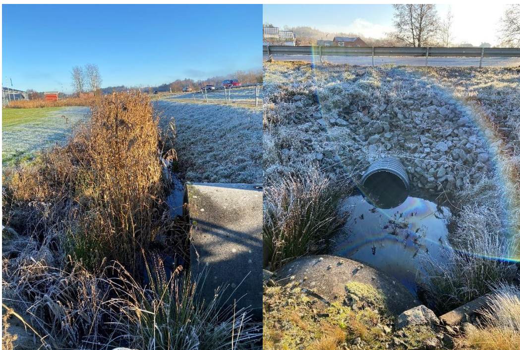
Figur 3-13. Till vänster: Dike utmed väg 169, söder om industriområdet Svanvik. Till höger: Utloppstrumma från industriområde till dike innan ny trumma under väg 169.
