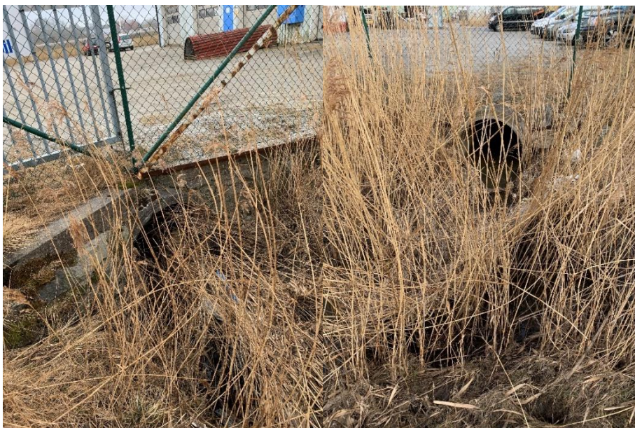
Figur 3-10. T.v.: Inlopp till kulvert i sträckan H-I. T.h.: Utlopp från kulvert i sträckan H-I.
