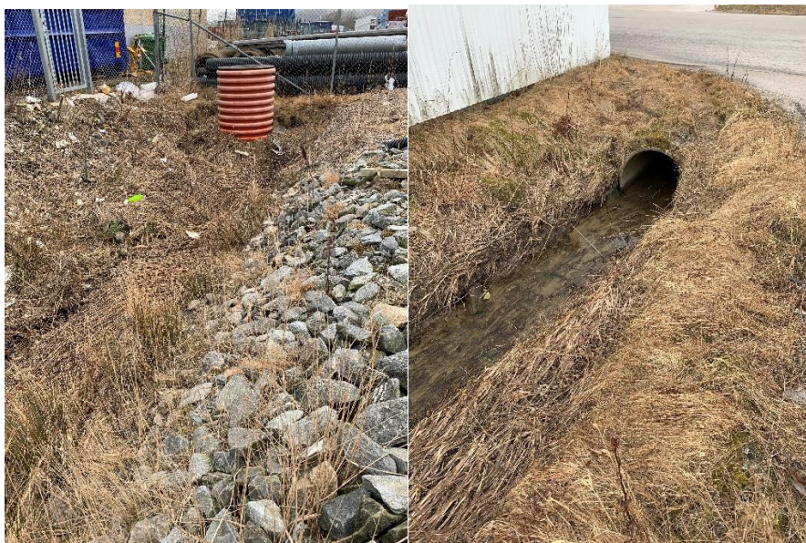
Figur 3-9. T.v.: Brunn i punkt E dit dagvatten i dike huvudsakligen leds. T.h.: Mynning av kulvert under industrimark, punkt G.
